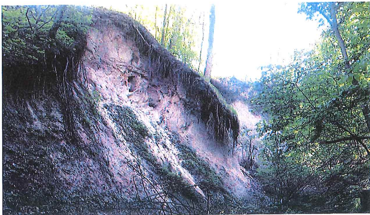
Zdj. 3. Skarpa główna w północnej części osuwiska
