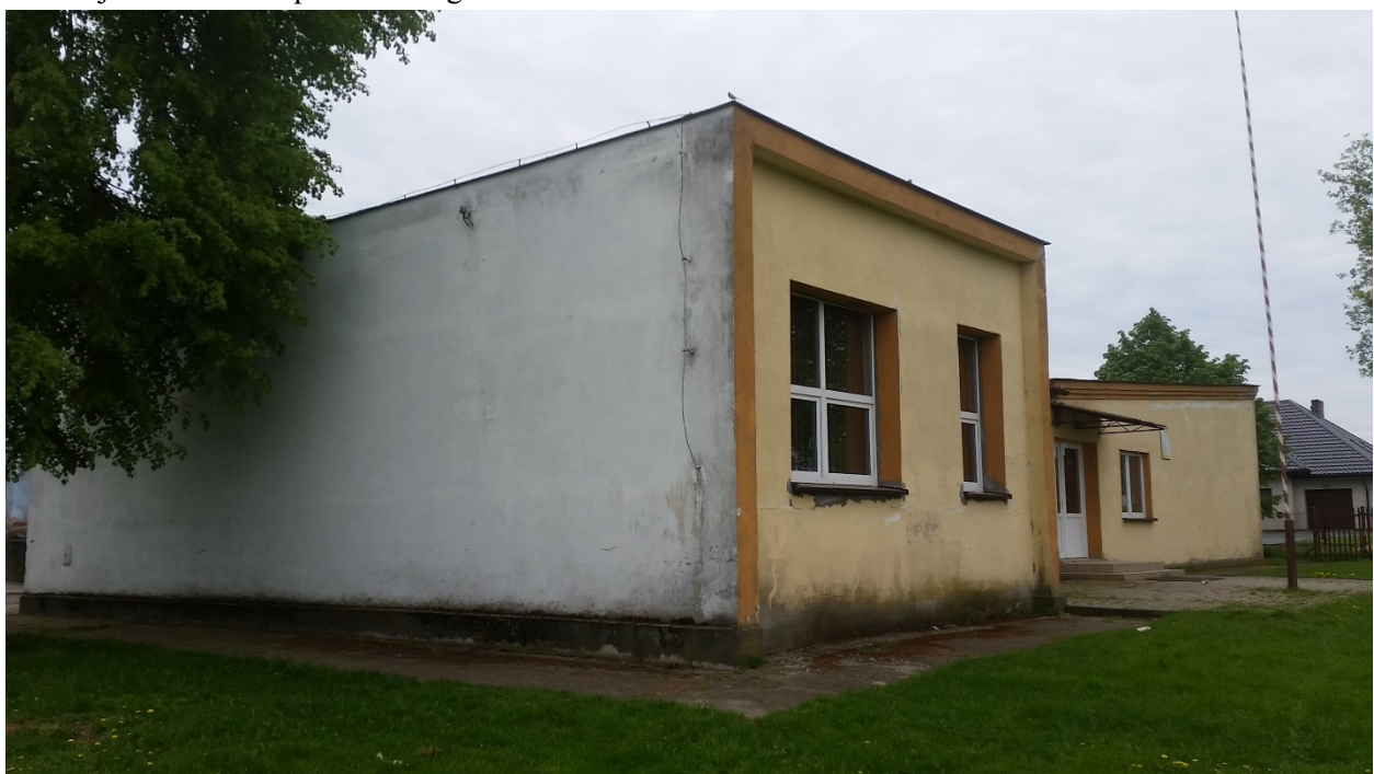
Elewacja wschodnia i północna segment B
